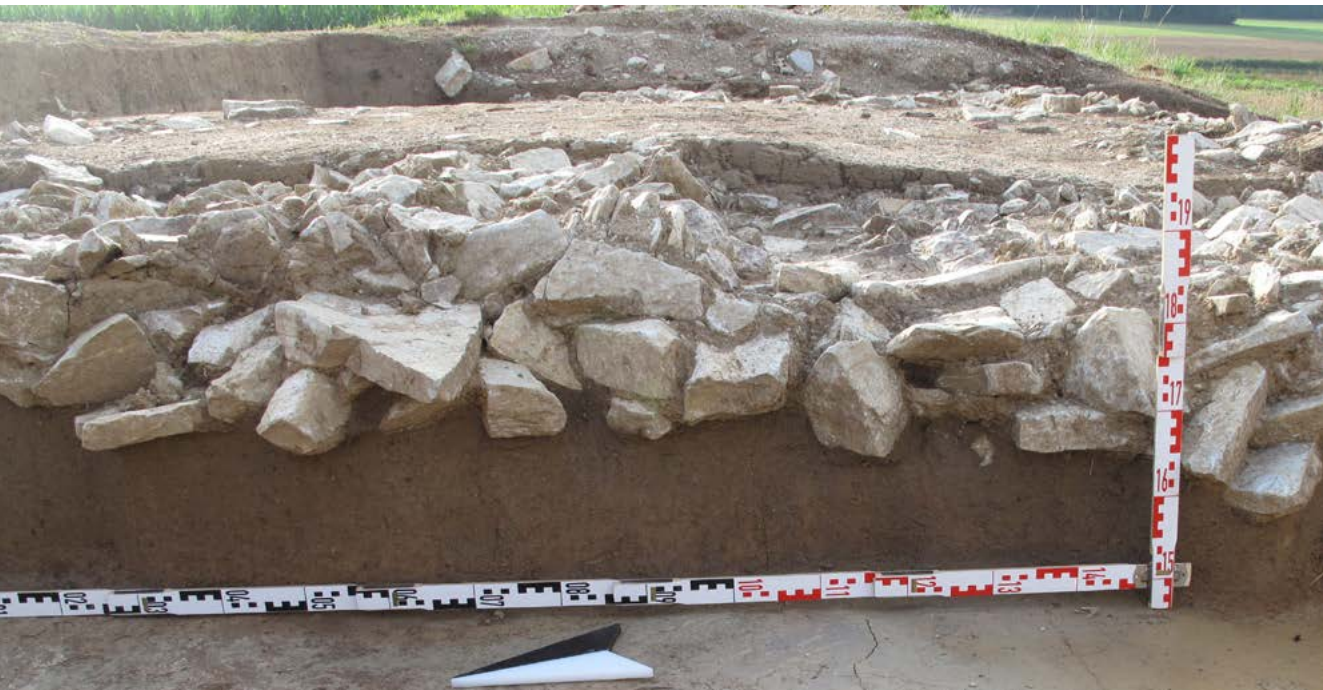
Abb. 5 | Aufbau des Straßenkörpers der Trasse bei Wettstetten-Echenzell.
